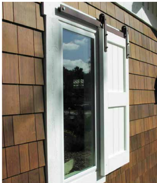
Okiennice przesuwne wyposażone w napęd
